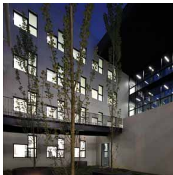
Centro Nanotecnologías UAB - Barcelona Arquitecto: RGA
